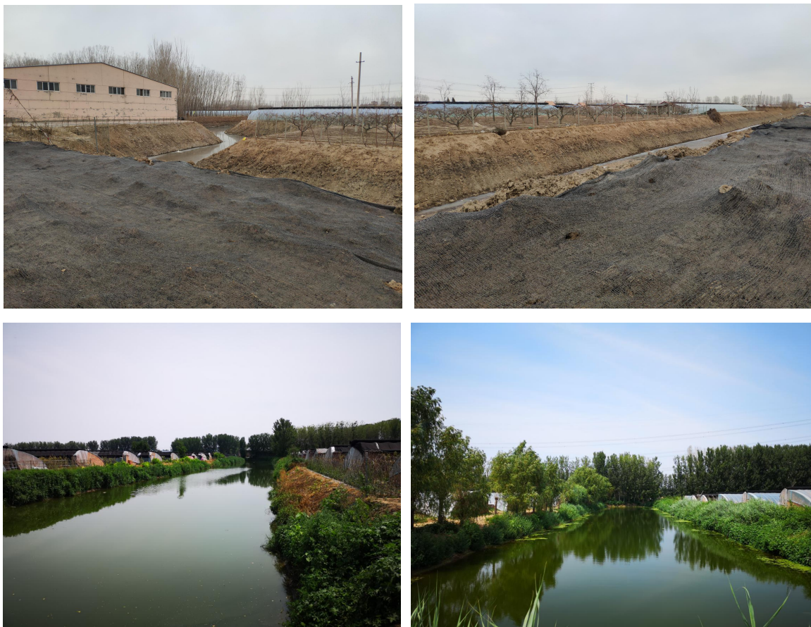
沟渠治理工程完工前后照片
