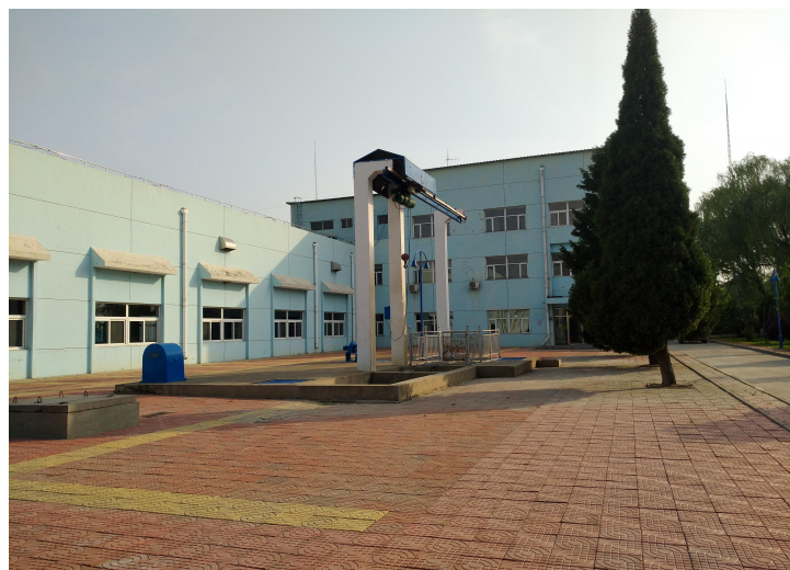
泵站主副厂房
