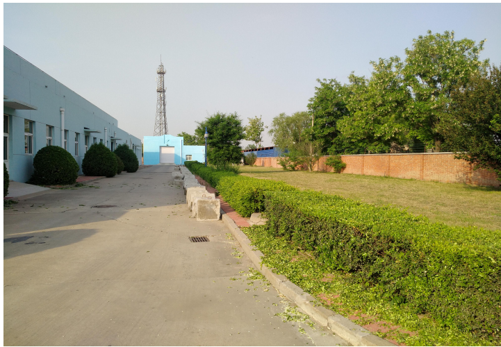
泵站场区绿化
